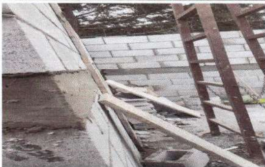
Foto 1: Sustrucción del muro de block.
