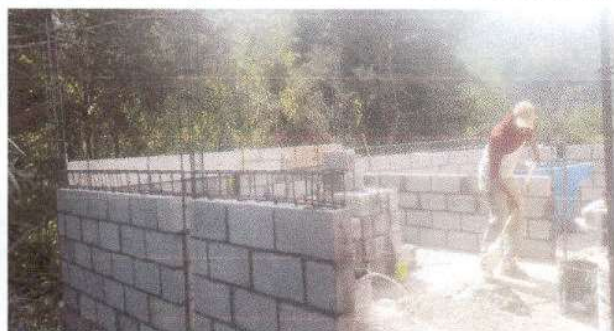
Foto 3: Sustrucción del muro de block.
