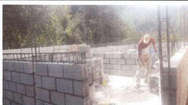
Foto 2: Sustrucción del muro de block.
