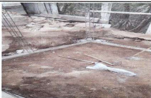
Foto 5: Sustrucción de piso de torta de concreto.
